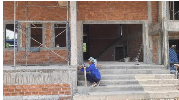
รูปที่ 5 งานก่อฉาบบ้านจัดจักร ลำพูน
