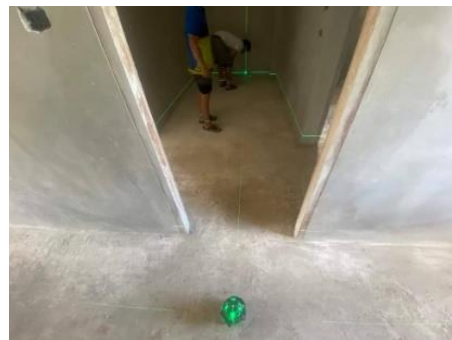
รูปที่ 3 การวัดคุณภาพงานก่อสร้าง บ้านจัดจักร
