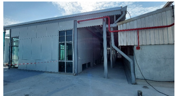
รูปที่ 13 โครงสร้างเหล็กส่วนที่ต่อเติม
