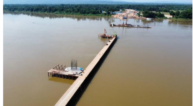
ข. บริเวณงานก่อสร้างสะพานมิตรภาพไทย-ลาว แห่งที่ 5 ช่วงข้ามแม่น้ำโขง
