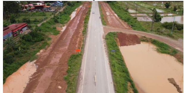
ง. งานตรวจสอบตำแหน่งการติดตั้งป้ายจราจรและทางเชื่อม
