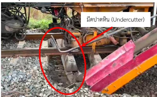
รูปที่ 3 การทำงานของมีดปาดหินได้หมอนรองราง
