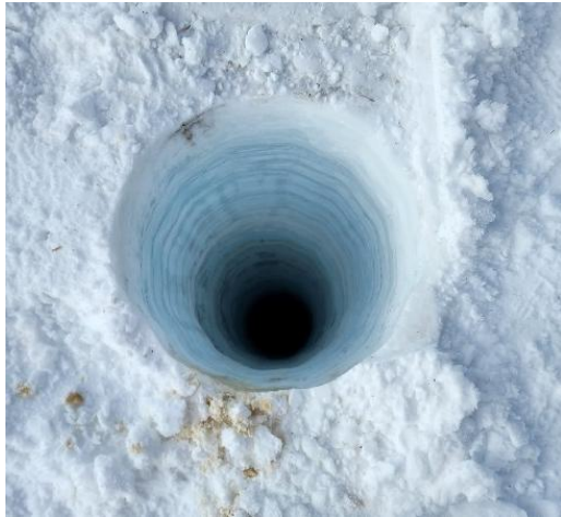
รูปที่ 5 การเจาะด้วยพลังงานความร้อน (Thermal Drilling) ในโครงการ IceCube Upgrade ในขณะที่ทำการติดตั้งหัวเจาะขึ้นจากหลุมหลังจากเสร็จสิ้นการกัก
