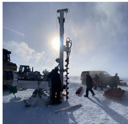
รูปที่ 2 การเจาะเชิงกล (Mechanical Drilling) ในโครงการ IceCube Upgrade
