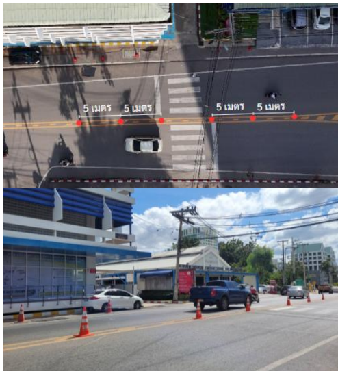
รูปที่ 6 ตัวอย่างการวางกรวยจราจรเพื่อจำลองเกาะพักกลางถนน
