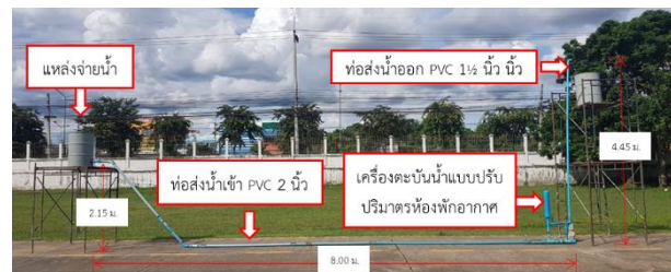
รูปที่ 3 การติดตั้งเครื่องสูบน้ำและอุปกรณ์ประกอบ
