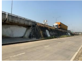
เชิงลาดสะพาน
