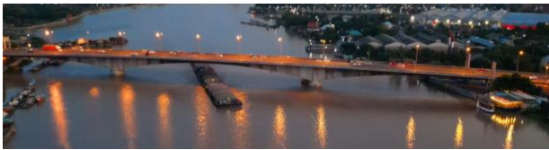
รูปที่ 1 สะพานปทุมธานี 2
