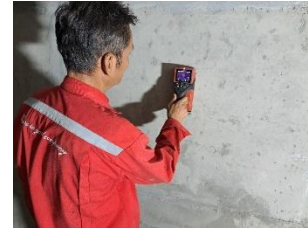
การสำรวจรายละเอียดเหล็กเสริม
