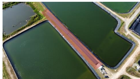
รูปที่ 6 บริเวณที่มีการติดตั้งระบบผลิตไฟฟ้าพลังงานแสงอาทิตย์ที่ฟาร์ม C
