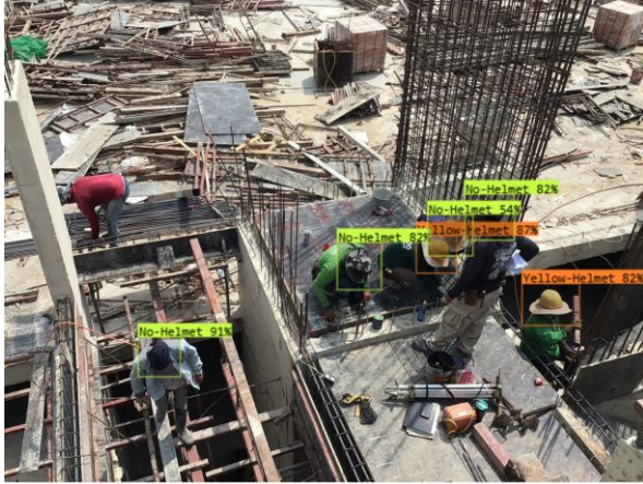
รูปที่ 6 ตัวอย่างการตรวจจับ ในกรณีไม่สวมหมวกนิรภัย
